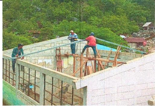
Foto 2: Colocación de estructura de techo
