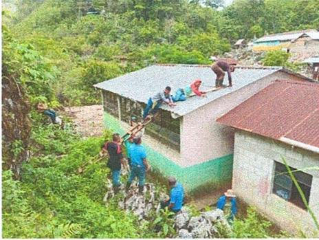
Foto1: Sustitución de cubierto de laminas
