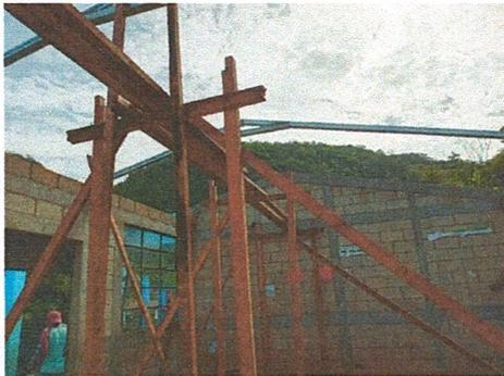
Foto 3: Sustitución de estructura de techo
